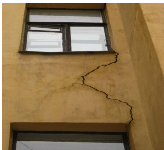
Рис. 6 – Растрескивание внутренних простенков
