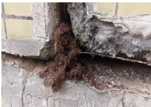
Рис. 2 – Разгерметизация межблочных и межпанельных швов
