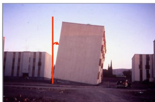
Рис. 3 – Крен стеновой панели
